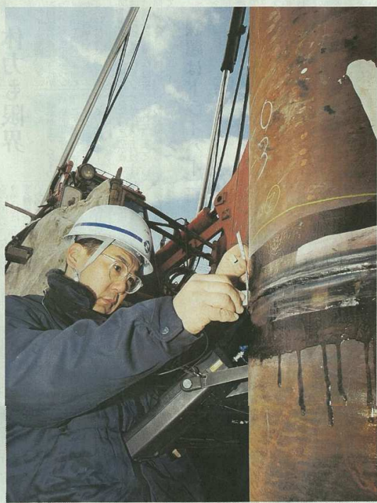
計測器の微妙な異常に鋭く目を光らせながら、超音波センサーを小刻みに動かす小林さん。「検査結果は、その場ですぐに見極めなければいけない」という緊張の中、作業に励む＝新潟市秋葉区西古津(写真部・佐藤勇夫撮影)
