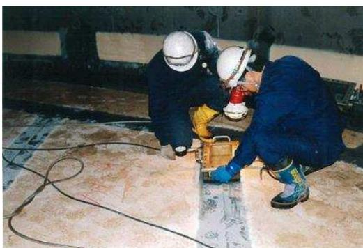
屋外貯槽タンク等の底板継手の漏洩試験
