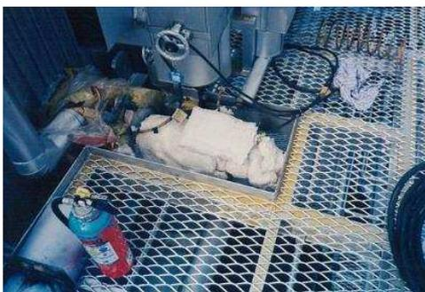
溶接完了後の焼鈍工事
